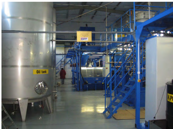
FIGURA 119. SISTEMA DE PENSADO EN FRÍO DE ACEITE DE ALMENDRAS, REPOSO EN TANQUES DE ACERO INOXIDABLE. FARMET
